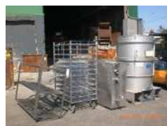
ステンレス解体
